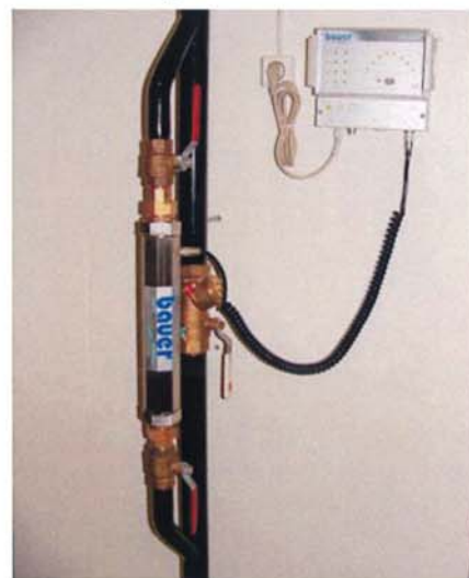
Installation med förbikoppling
