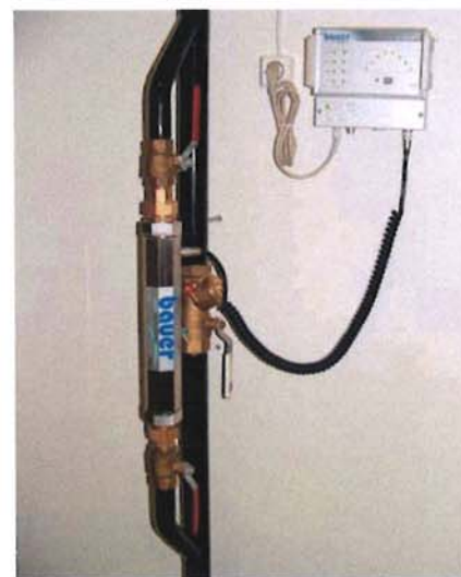
Installation med förbikoppling
