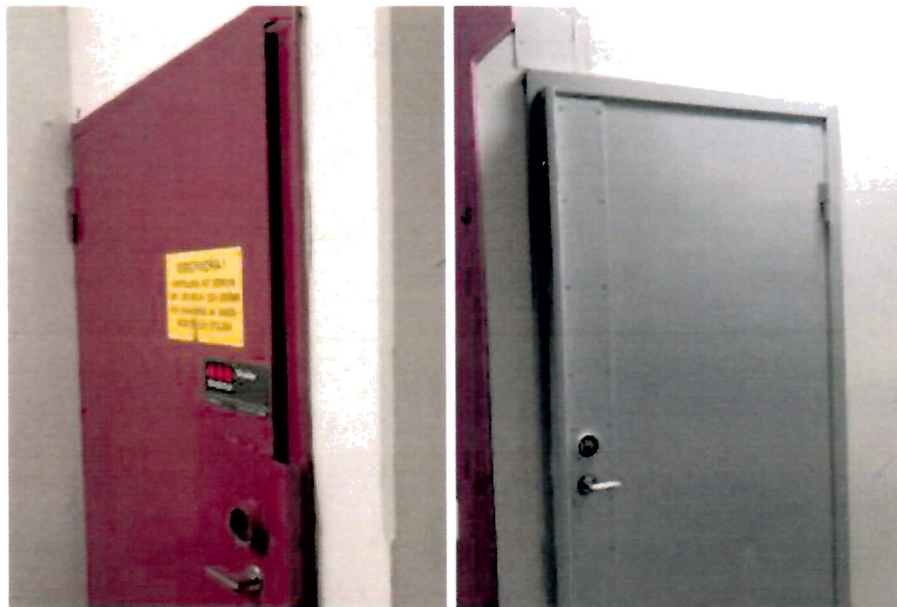
Figur 11 - Berörda dörrar i brandcellsgräns som ej sluter tätt.
